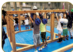
みんなで協力して重い柱を取り付け。
