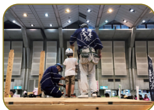
二階に登って柱をつける作業。
